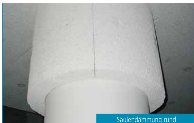
Dämmplatte mitbetoniert
