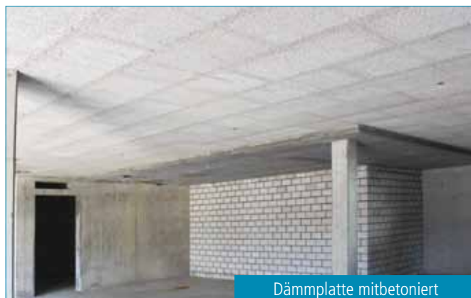
Einlegen in die Schalung
